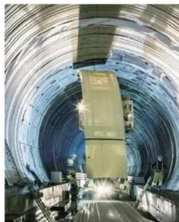
Acciona开发的创新型复合板材证明是隧道施工这种苛刻施工工作的最佳解决方案，因为它们能够满足所有技术挑战，同时符合与此类型应用相关的阻燃要求。
