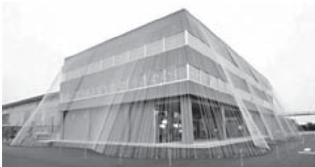
建筑师隈研吾，与建筑材料生产商小松精练株式会社合作，利用碳纤维为一幢3层高的小松精练办公大楼抗震，日本潮流网站Japan Trends指出，这是全球首幢碳纤维抗震建筑。大楼主体以混凝土建成，以碳纤维作地基，并由外表看似青草的海绵状陶瓷物料包围，屋顶还有空中花园，依靠雨水灌溉植物。隈研吾使用小松精练的招牌产品热塑性碳纤维物料CABKOMA，制成包围整幢建筑的碳纤维杆。小松精练指出，CABKOMA拥有高拉伸性、外表美观、结构强韧及重量轻等优点。
