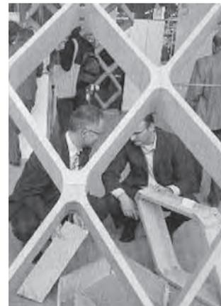
图12 用纤维增强混凝土构件制成的长斜方形结构
