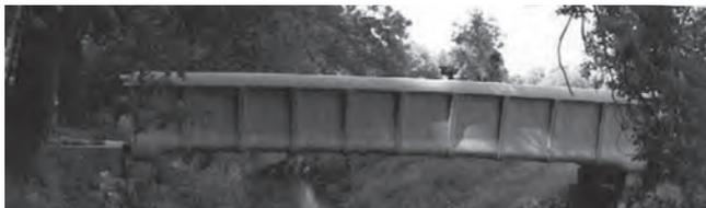
图8 用聚合物涂层基布增强的用于步行和自行车的天桥
