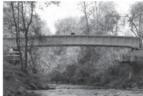
图9 轻量型的复合材料桥梁
